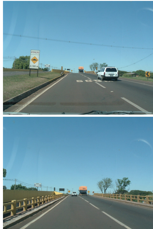
FIGURA 6: Aproximação 1a da Av. Pion. João Pereira (2)
