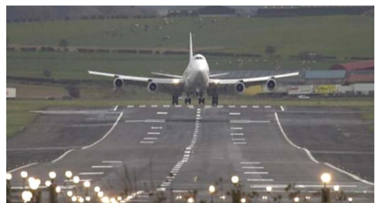
FIGURA 8: Ejemplo de Irregularidad en el Perfil de Pavimento de Pista de Aeropuerto
